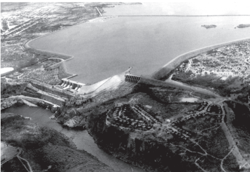
Figura 2 – Hidrelétrica de Paulo Afonso.
