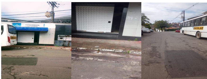
Figura 6 – Entrada da Escola – degraus na Entrada - Rua onde situada a Escola 3
