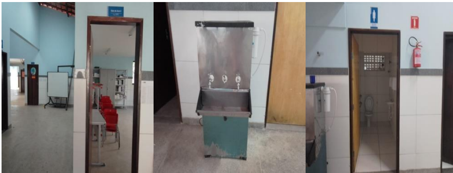
Figura 10 – Porta da sala de aula Figura 11 – Bebedouro Figura 12 – Porta do banheiro
