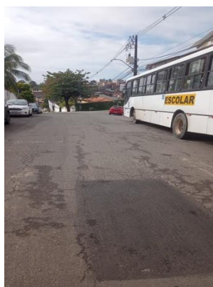
Figura 27–Rua onde situada a Escola 3
