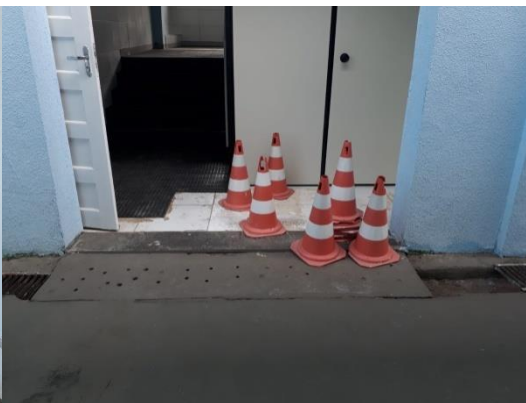
Figura 15 – Rampa na segunda entrada da Escola 2
