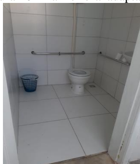
Figura 16 - Banheiro c/ adaptações
