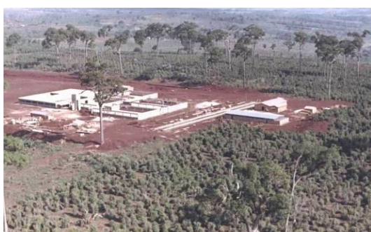
Figura 9 - Construção do Centro de Ciências Biológicas na UEL em 1968
