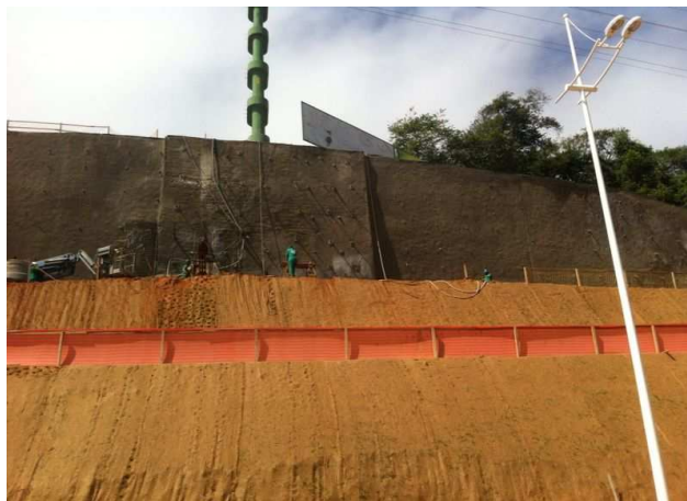
Figura 4 - Uso de solo-grampeado para a fatia com 90° Fonte: Grupo de Pesquisa - LAGEO 2014
