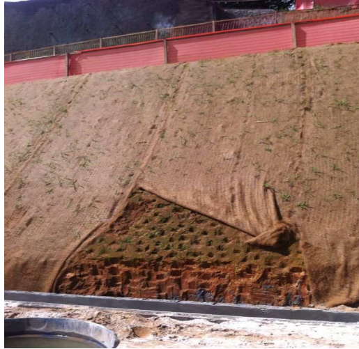
Figura 3 - Uso de Biomanta em Inclinações com 65° Fonte: Grupo de Pesquisa - LAGEO 2014
