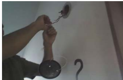
Fig. 7: Recolocando o Spot da luminária.
