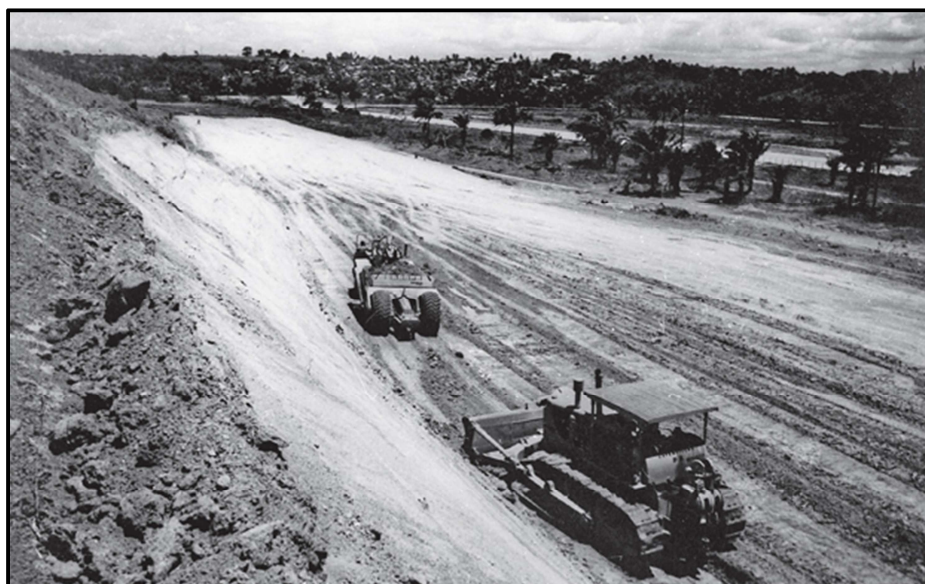
Imagem 1 – Máquinas dão início às obras da Avenida Paralela, na década de 70.
